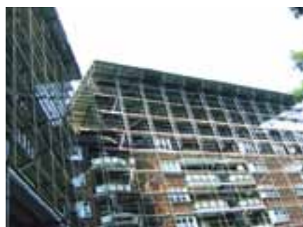
Einrüstung eines Mehrfamilienhauses in Hamburg.
